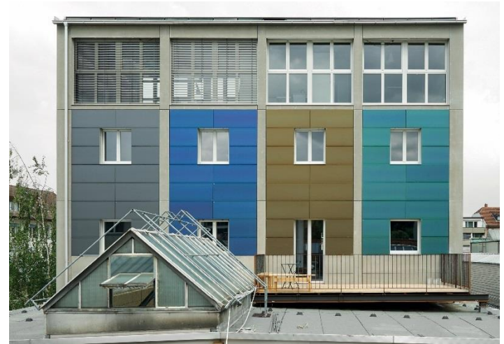
Bâtiment multi-usage «Kohlesilo», Bâle. Installation PV en façade et toiture, couvrant 37% du besoin total en énergie. Prix Solaire Suisse 2015
