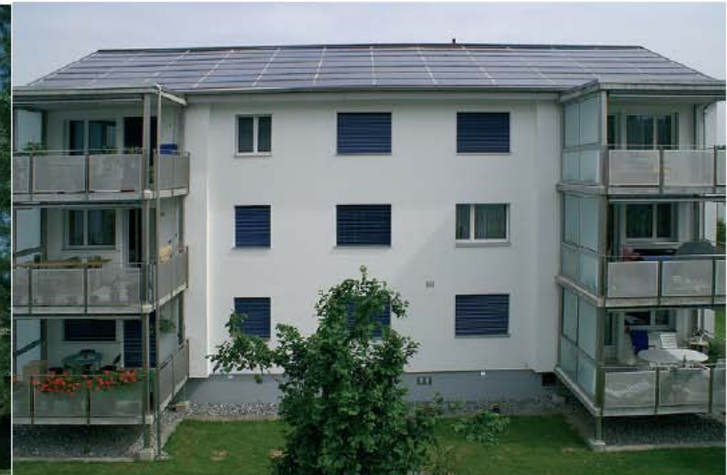
Après les rénovations
