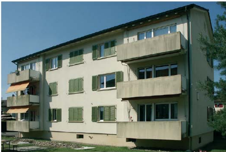
Avant les rénovations
