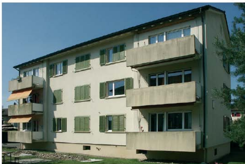
Avant les rénovations
