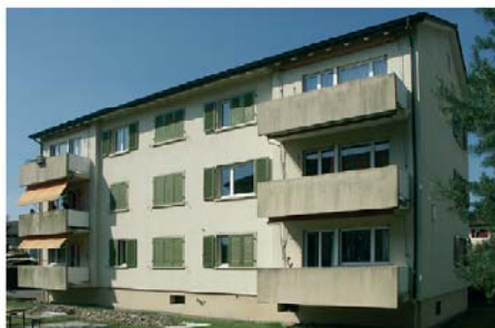
Avant les rénovations
