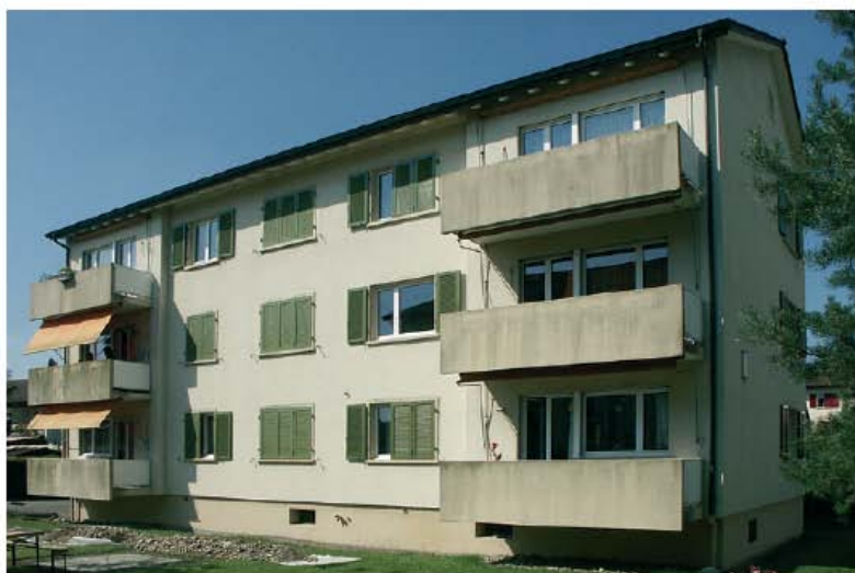
Avant les rénovations
