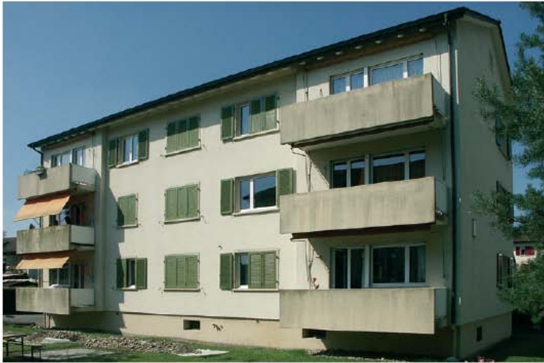
Avant les rénovations
