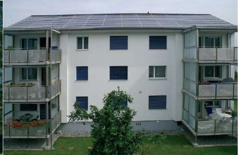
Après les rénovations
