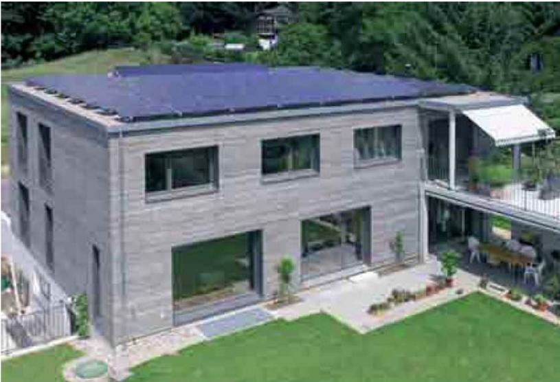
*Dieses Haus speist jährlich einen Stromüberschuss von 8054 kWh ins Netz ein. Es produziert insgesamt 18 500 kWh Sonnenstrom und Solarwärme, verbraucht davon aber nur 7060 kWh und stellt so ein kleines Kraftwerk dar. Die Kosten für den Bau des Hauses lagen 12 Prozent über jenen für ein konventionelles Haus dieser Grösse.*
